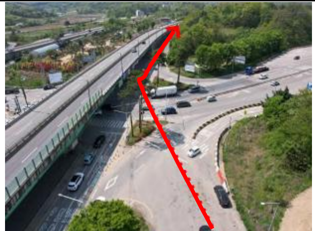
송수계통, 02(02)구간, Sta. No. 34+0.00 관로노선 현황
