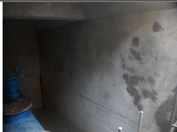
송수계통, 02구간, Sta. No. 109+3.1[Mb] 구조물 상태양호
