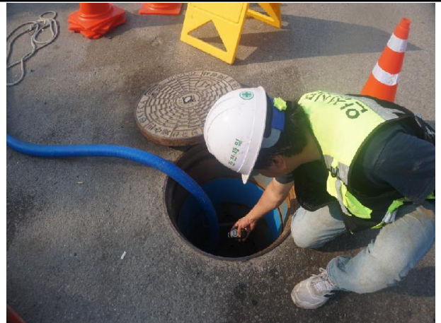
송수계통, 02구간, Sta. No. 34+0.0[M] 유해가스농도 측정
