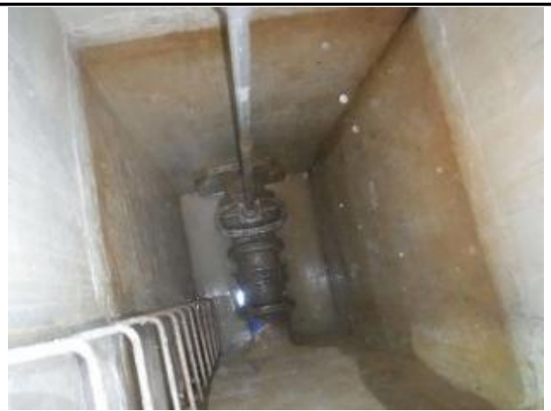
송수계통, 02구간, Sta. No. 2.+17.0[D] 이토밸브 내부 전경
