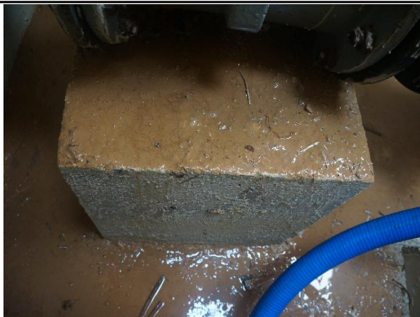
송수계통, 02구간, Sta. No. 67+32.6[D] 이토밸브실 받침콘크리트 상태양호
