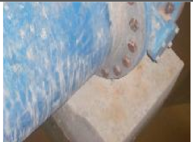
송수계통, 02구간, Sta. No. 109+3.1[Mb] 받침콘크리트 상태양호
