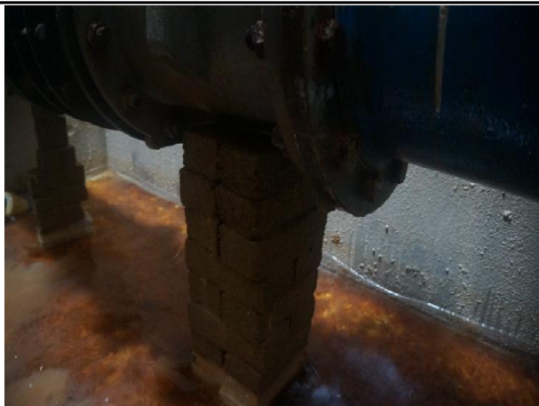
송수계통, 02구간, Sta. No. 31+18.6[D] 밸브 받침콘크리트 조적시공
