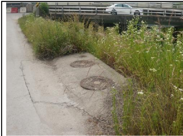
송수계통, 02구간, Sta. No. 2.+17.0[D] 이토밸브 외부 전경
