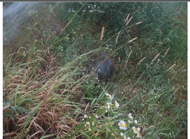
송수계통, 02구간, Sta. No. 31+18.6[D] 토출구 및 배출수역 상태양호
