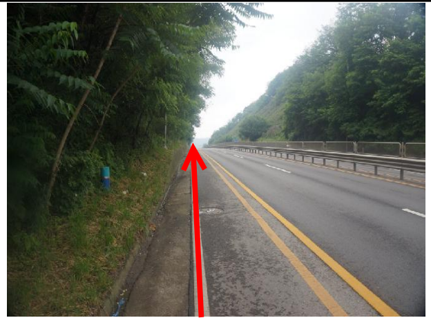
송수계통, 02(03)구간, Sta. No. 84+17.50 관로노선 현황
