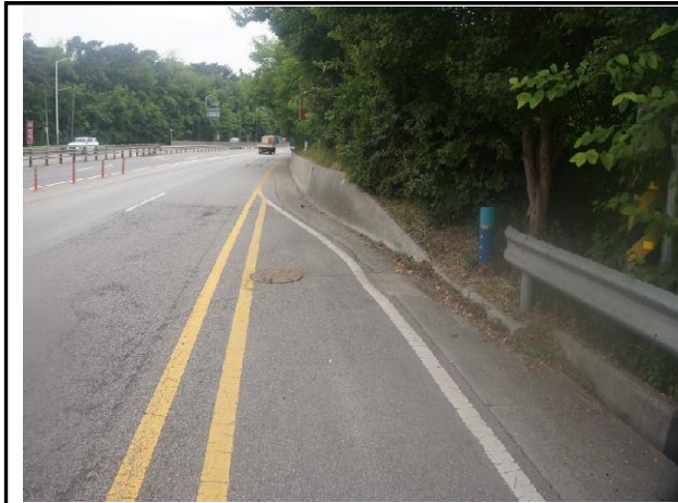
송수계통, 02구간, Sta. No. 45+8.3[A] 공기밸브실 외부 전경
