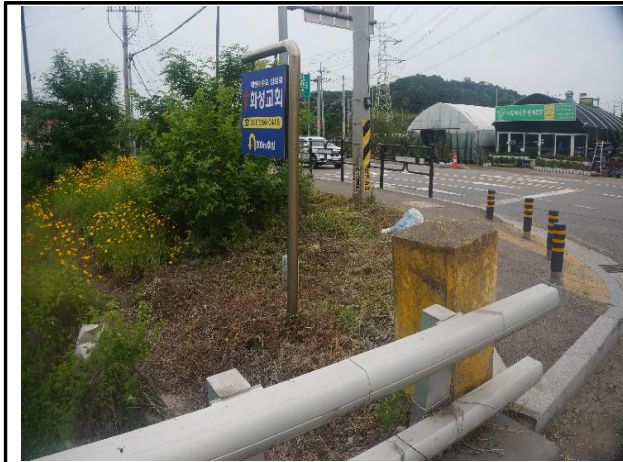
송수계통, 02구간, Sta. No. 108+4.0[D] 이토밸브실 외부 전경
