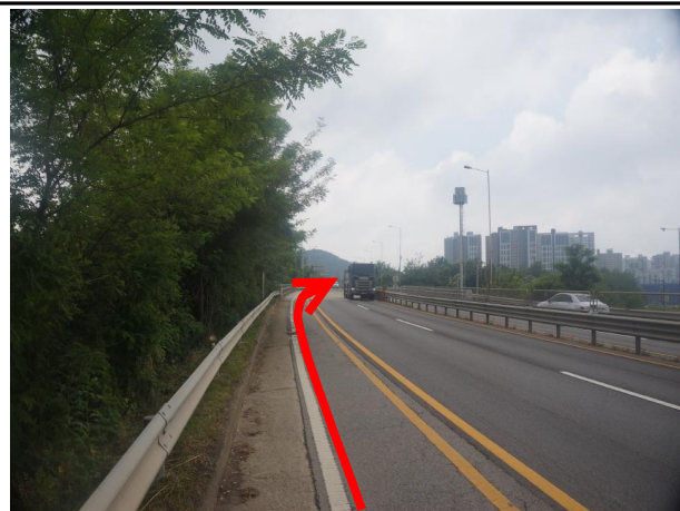
송수계통, 02(03)구간, Sta. No. 65+25.0 관로노선 현황
