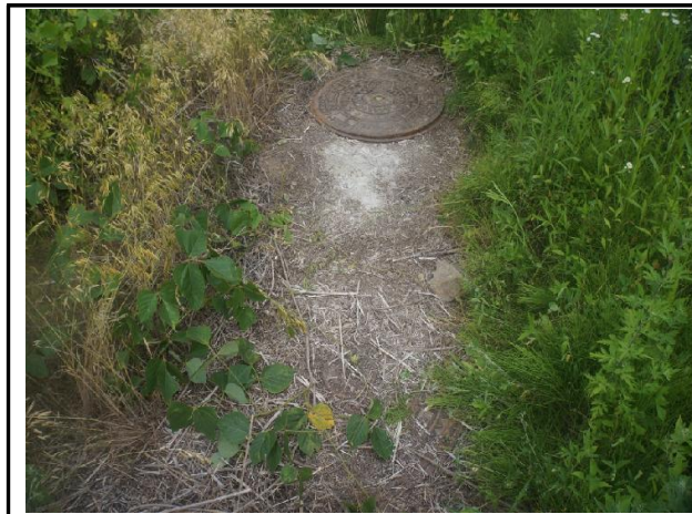
송수계통, 02구간, Sta. No. 67+32.6[D] 이토밸브실 외부 전경
