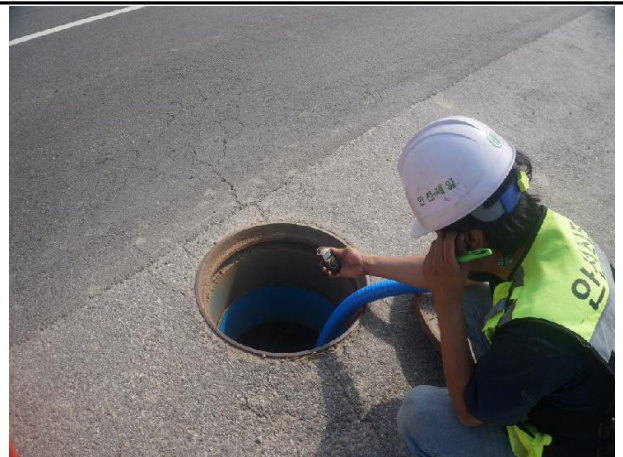
송수계통, 02구간, Sta. No. 1+22.0[A] 유해가스농도 측정
