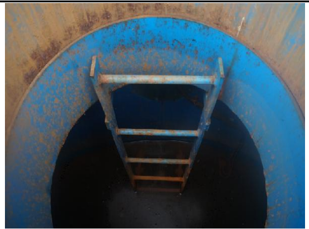
송수계통, 02구간, Sta. No. 45+8.3[A] 공기밸브실 내부 전경
