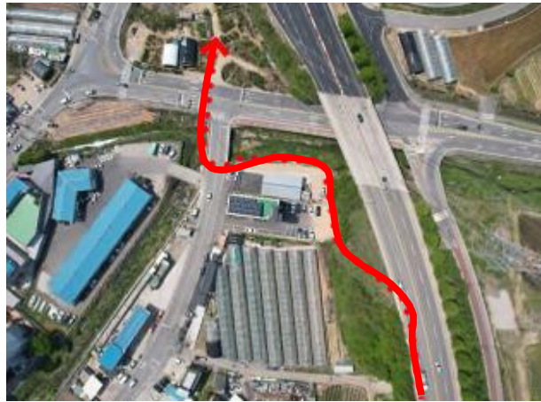
송수계통, 02(04)구간, Sta. No. 104+11.0 관로노선 현황
