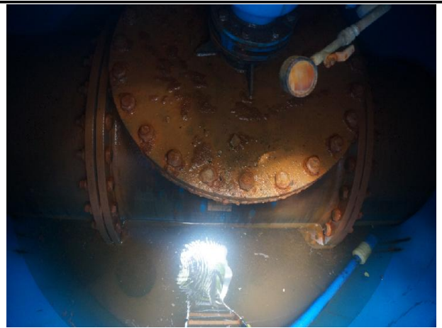
송수계통, 02구간, Sta. No. 84+17.5[A] 공기밸브실 내부 전경
