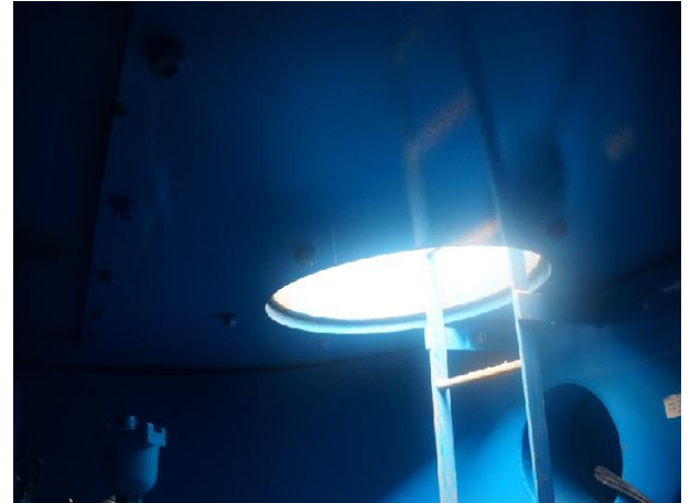
송수계통, 02구간, Sta. No. 65+25.0[A] 구조물 상태양호
