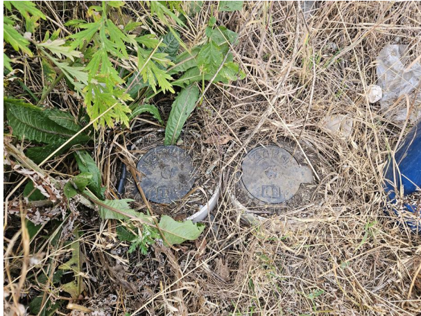
송수계통, 02(01)구간, Sta. No. 15+3.7[A] 공기밸브실 T/B 전경
