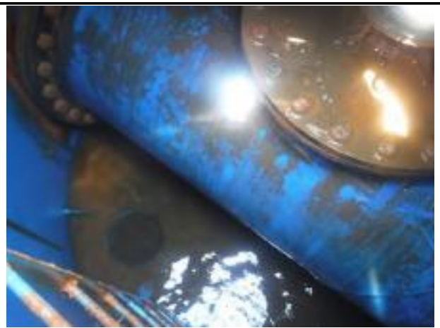
송수계통, 02구간, Sta. No. 15+3.7[A] 공기밸브실 내부 전경
