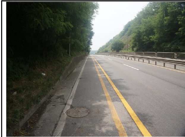
송수계통, 02구간, Sta. No. 84+17.5[A] 공기밸브실 외부 전경
