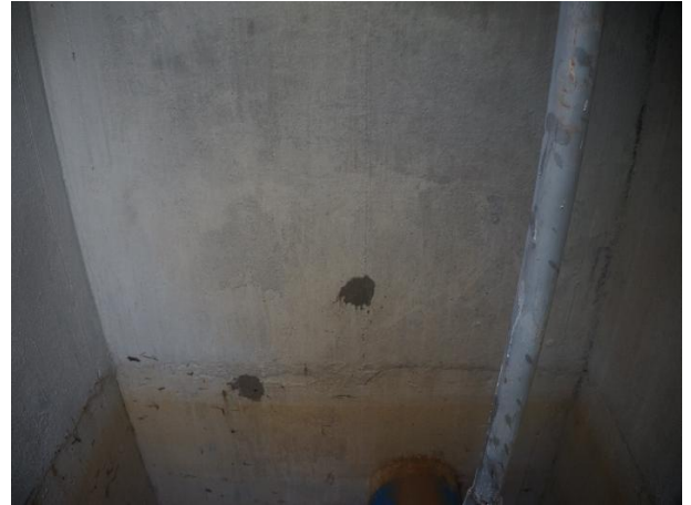
송수계통, 02구간, Sta. No. 67+32.6[D] 구조물 상태양호
