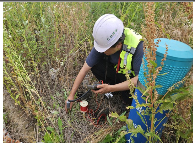
송수계통, 02(02)구간, Sta. No.34+0.0[M] 제수밸브실 관대지 전위차 측정
