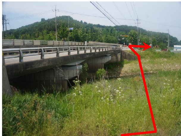
송수계통, 02(01)구간, Sta. No. 2+10.50 동화천 횡단구간
