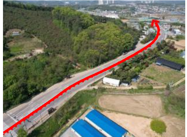
송수계통, 02(01)구간, Sta. No. 6+0.00 관로노선 현황
