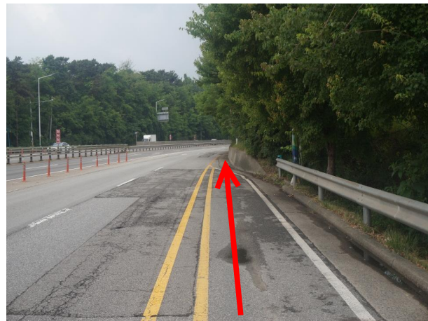
송수계통, 02(02)구간, Sta. No. 45+8.30 관로노선 현황
