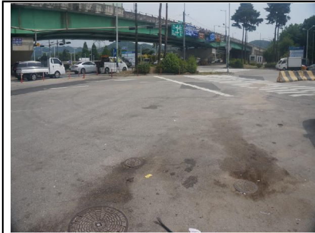
송수계통, 02구간, Sta. No. 34+0.0[M] 제수밸브실 외부 전경
