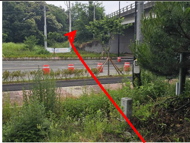
송수계통, 02(03)구간, Sta. No. 66+0.20 관로노선 현황
