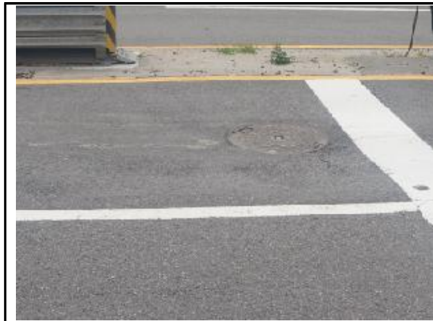
송수계통, 02구간, Sta. No. 15+3.7[A] 공기밸브실 외부 전경
