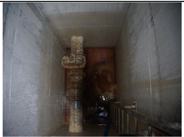
송수계통, 02구간, Sta. No. 31+18.6[D] 이토밸브실 내부 전경
