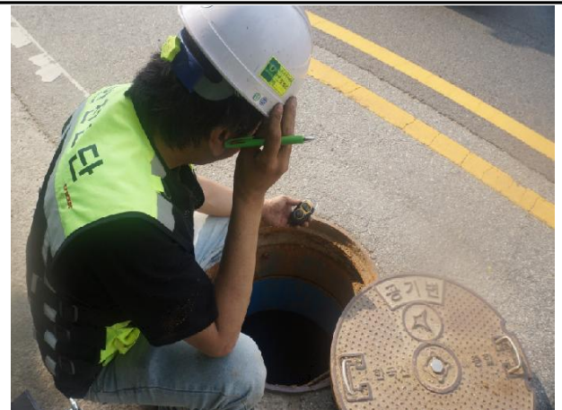
송수계통, 02구간, Sta. No. 65+25.0[A] 유해가스농도 측정
