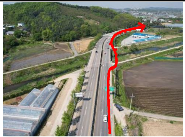
송수계통, 02(01)구간, Sta. No. 0+0.00 관로노선 현황
