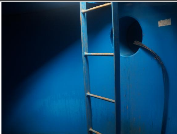
송수계통, 02구간, Sta. No. 65+25.0[A] 사다리 상태양호
