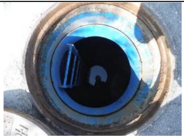
송수계통, 02구간, Sta. No. 65+25.0[A] 공기밸브실 내부 전경
