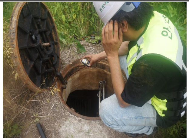
송수계통, 02구간, Sta. No. 67+32.6[D] 유해가스농도 측정
