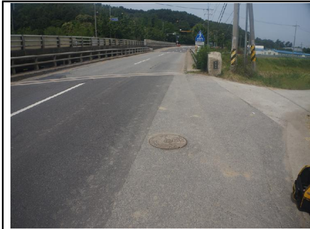
송수계통, 02구간, Sta. No. 1+22.0[A] 공기밸브 외부 전경
