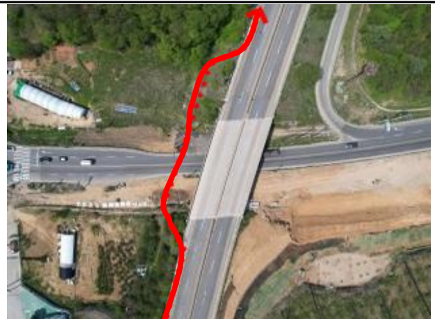
송수계통, 02(03)구간, Sta. No. 66+0.00 관로노선 현황
