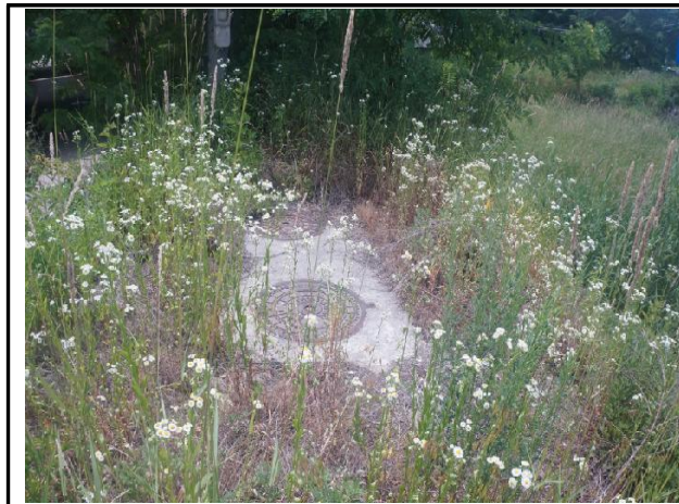
송수계통, 02구간, Sta. No. 31+18.6[D] 이토밸브실 외부 전경
