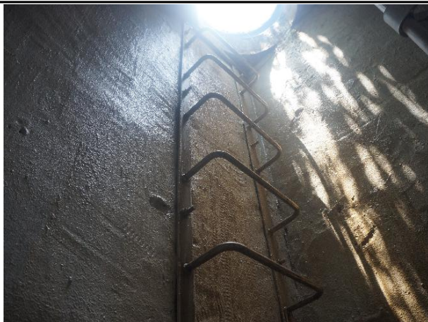
송수계통, 02구간, Sta. No. 108+4.0[D] 사다리 상태양호
