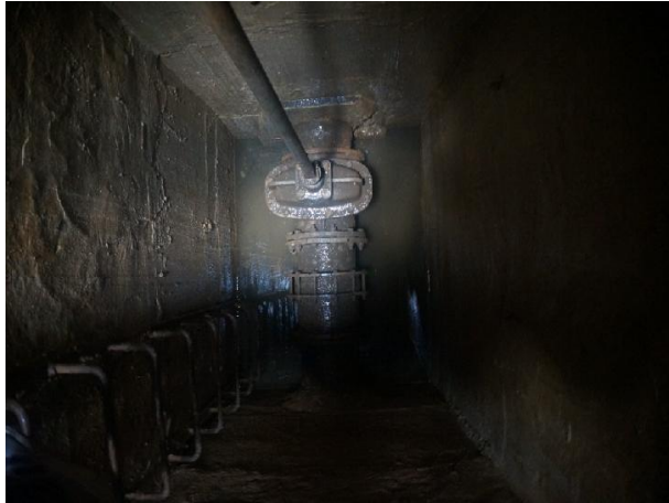
송수계통, 02구간, Sta. No. 2.+17.0[D] 배관 및 밸브 상태 양호
