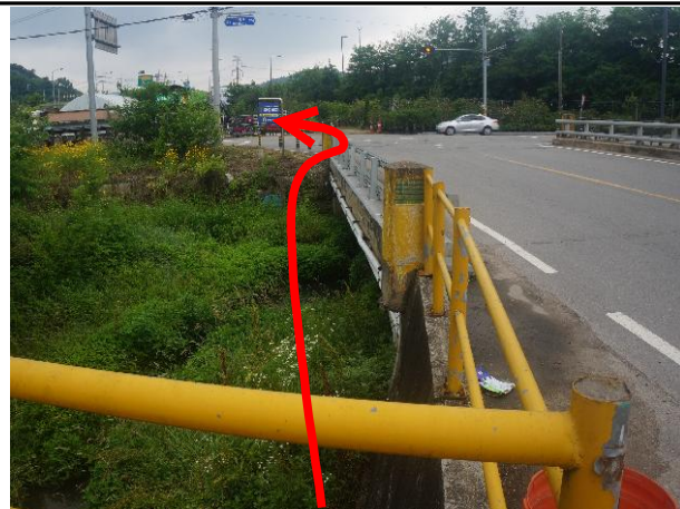
송수계통, 02(04)구간, Sta. No. 104+11.0 남진천 횡단구간
