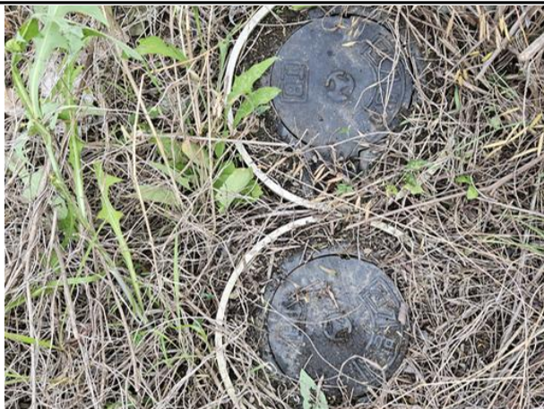
송수계통, 02(02)구간, Sta. No.34+0.0[M] 제수밸브실 T/B 전경
