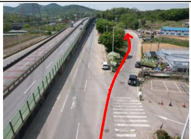
송수계통, 02(02)구간, Sta. No. 28+31.00 관로노선 현황
