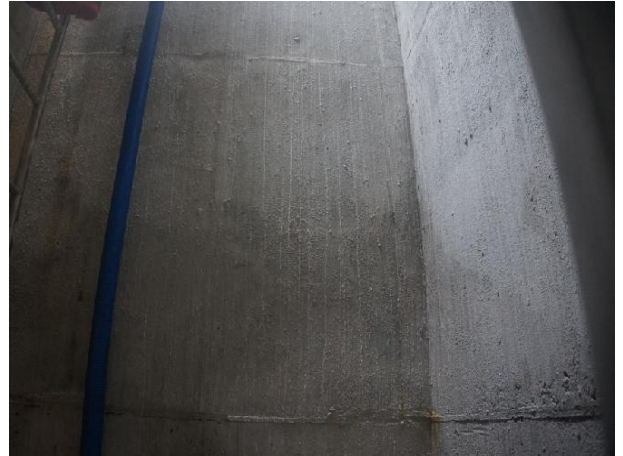
송수계통, 02구간, Sta. No. 31+18.6[D] 구조물 상태양호
