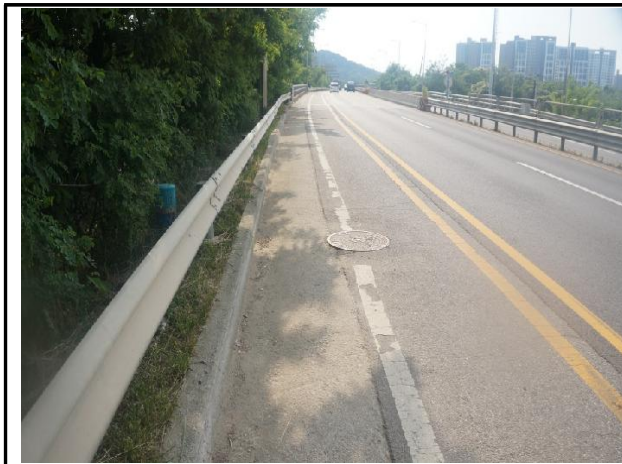
송수계통, 02구간, Sta. No. 65+25.0[A] 공기밸브실 외부 전경
