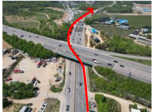
송수계통, 02(03)구간, Sta. No. 55+0.00 관로노선 현황
