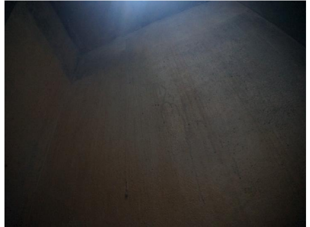
송수계통, 02구간, Sta. No. 2.+17.0[D] 구조물 상태양호
