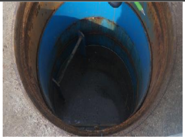
송수계통, 02구간, Sta. No. 34+0.0[M] 제수밸브실 내부 전경
