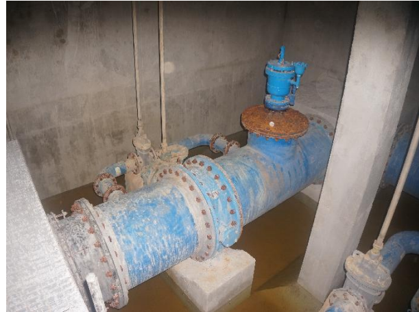
송수계통, 02구간, Sta. No. 109+3.1[Mb] 배관 및 밸브 상태양호
